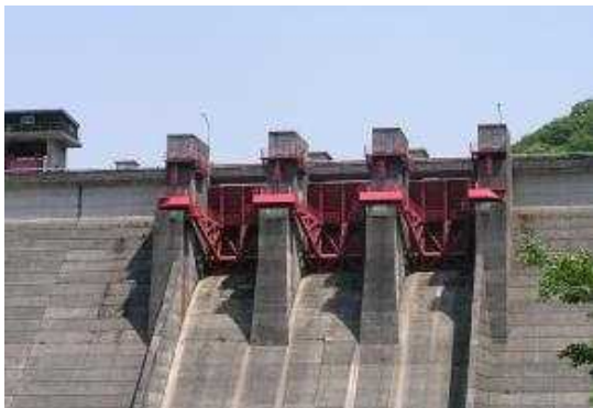
非常用洪水吐（クレストゲート3門）
