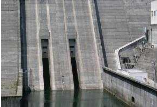
常用洪水吐（コンジットゲート2門）
