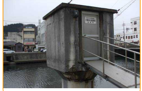
水位局(大橋水位局)
