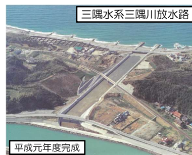
三隅川放水路（河川整備状況）
