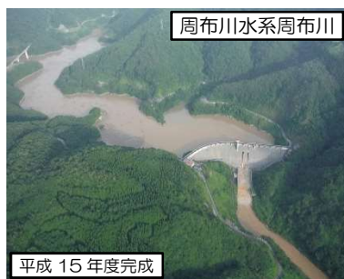
大長見ダム（出水状況）
