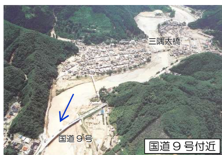
被災状況(三隅川)
