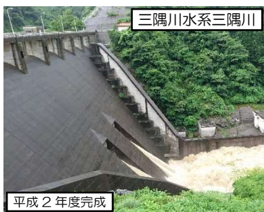
御部ダム（出水状況）
