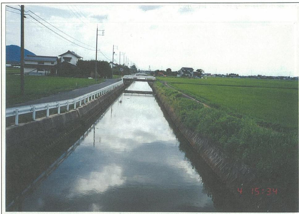
写真-22.3 高瀬川護岸（徳島橋付近）
