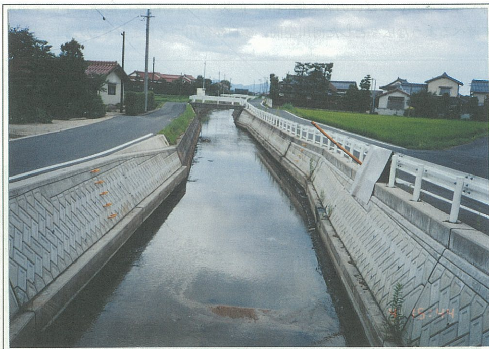
写真-22.4 高瀬川護岸（二宮橋付近）
