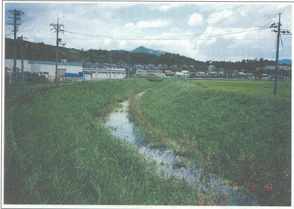
写真-22.5 江尻川護岸（新建川合流点付近）
