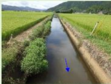
中津水門付近
