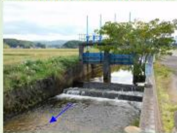
一本松頭首工
