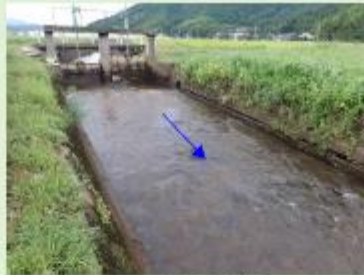
西中津水門付近
