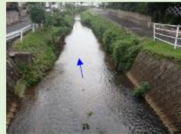
木戸川橋下流
