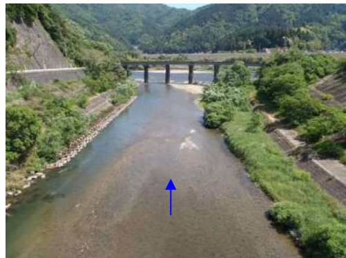
⑩八戸川 (近原橋下流)
