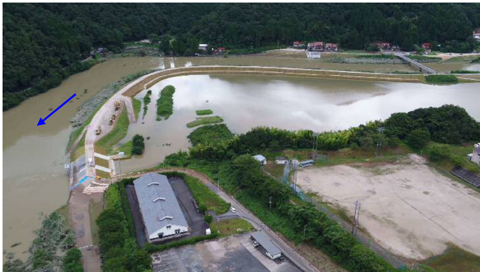
写真-3.1.8 八戸川：江津市桜江町小田（令和3年8月）
