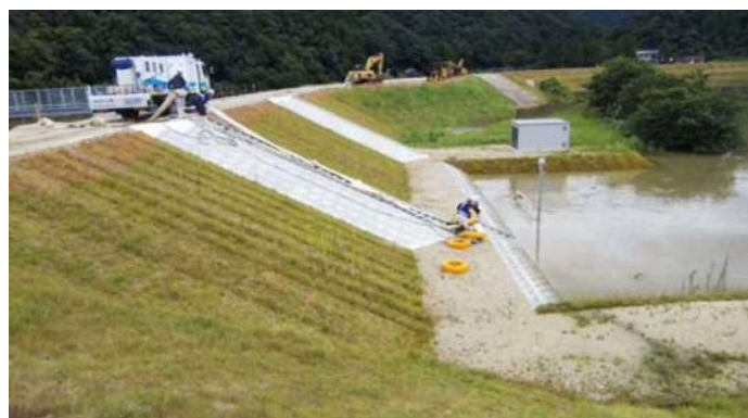
写真-3.1.9 八戸川：江津市桜江町小田（令和3年8月）
