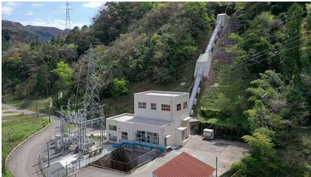
写真-3.2.1 八戸川第一発電所
