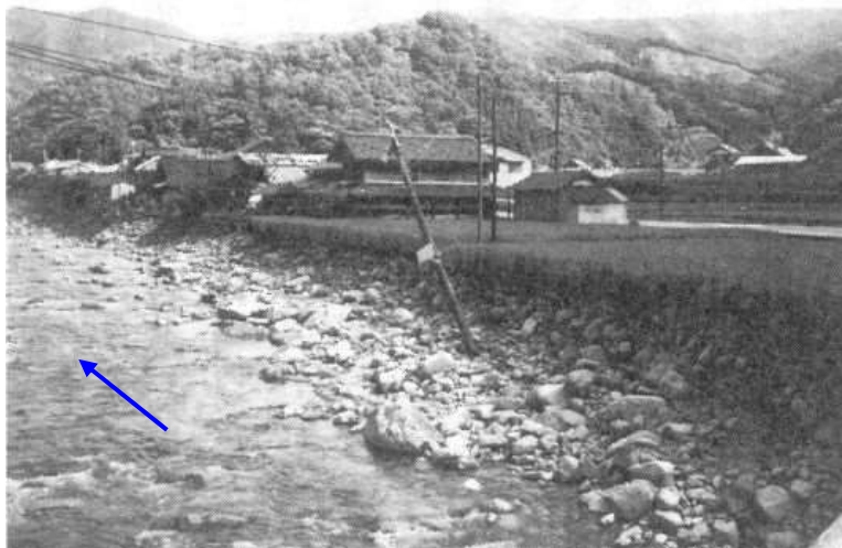
写真-3.1.2 八戸川：浜田市旭町市木（昭和58年7月）
