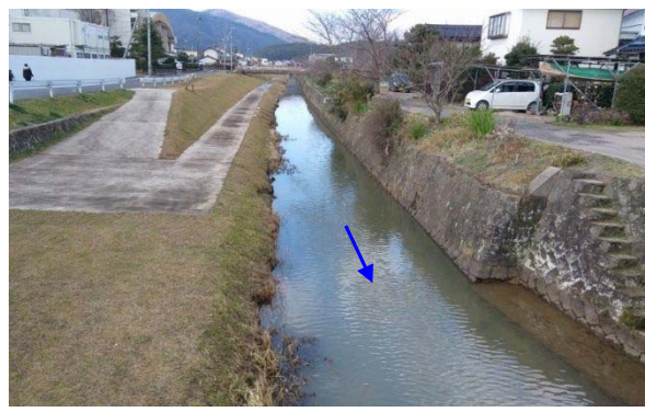
交友橋上流付近
