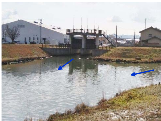
平田船川樋門 C (平田船川側)
