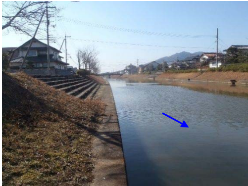
昭和橋上流付近
