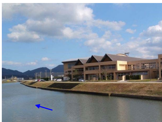
薬師橋下流 平田中学校付近
