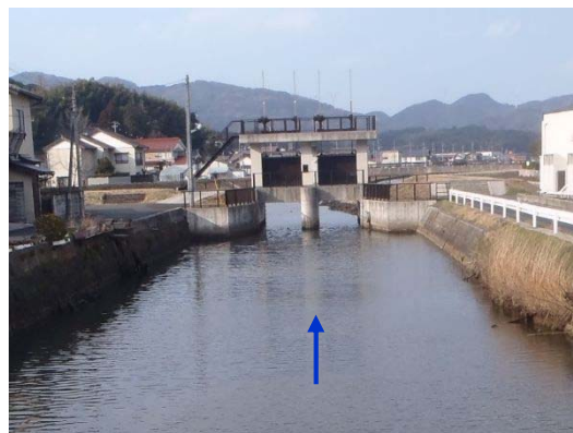
平田船川樋門 C (雲洲平田船川側)
