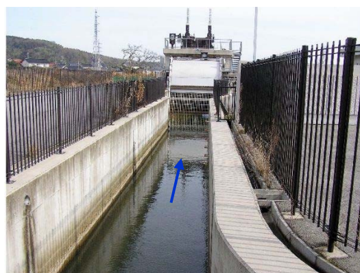
湯谷川排水機場流入水路
