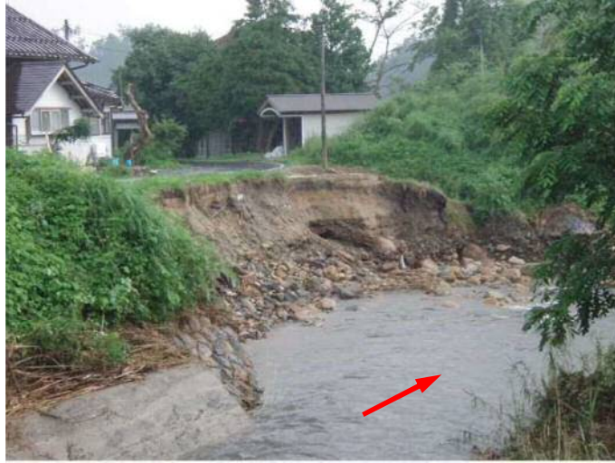
写真-3.1.1 斐伊川横田地区（平成 18 年 7 月）
