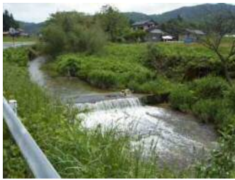
④神戸屋井堰
