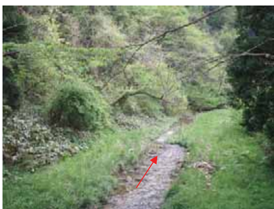
上流狭窄部（千坊橋下流）
