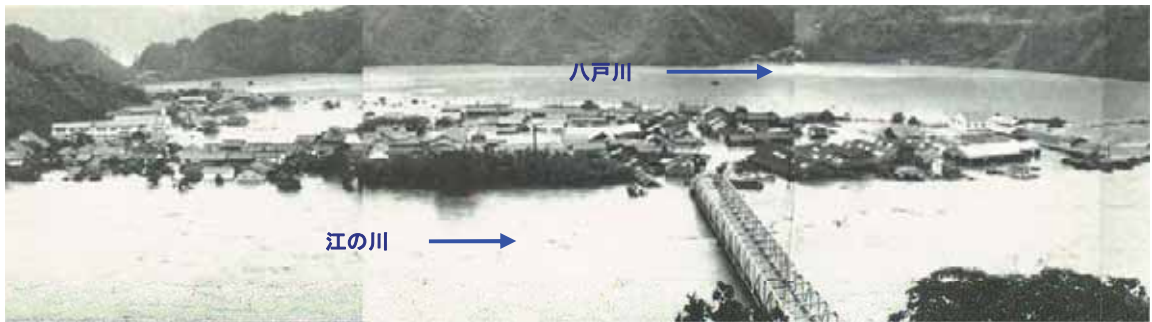
写真-3.1.1 八戸川：江津市桜江町川戸（昭和47年7月）
