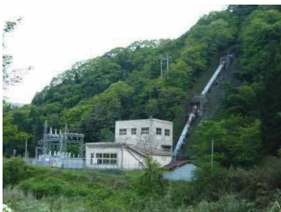
写真-3.2.1 八戸川第一発電所
