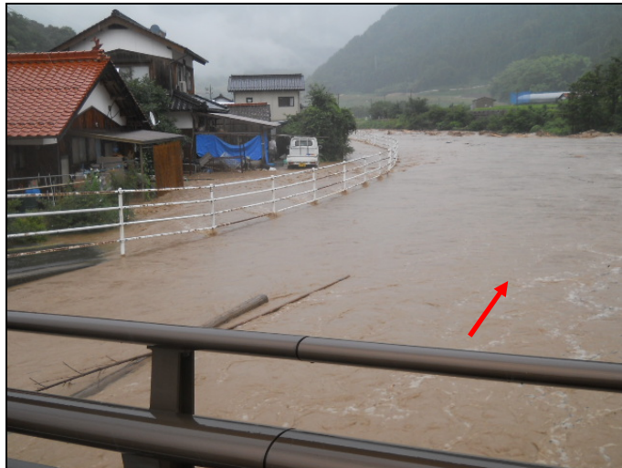
写真-3.1.4 津和野川：津和野町鷺原（平成 25 年 7 月）
