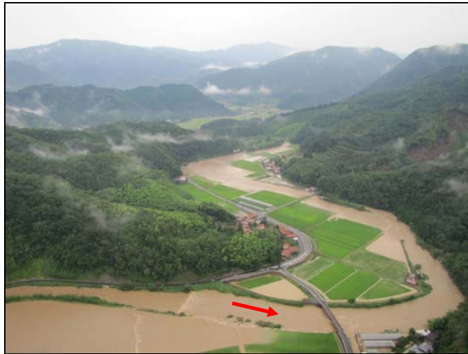
写真-3.1.5 津和野川：津和野町田二穂（平成 25 年 7 月）
