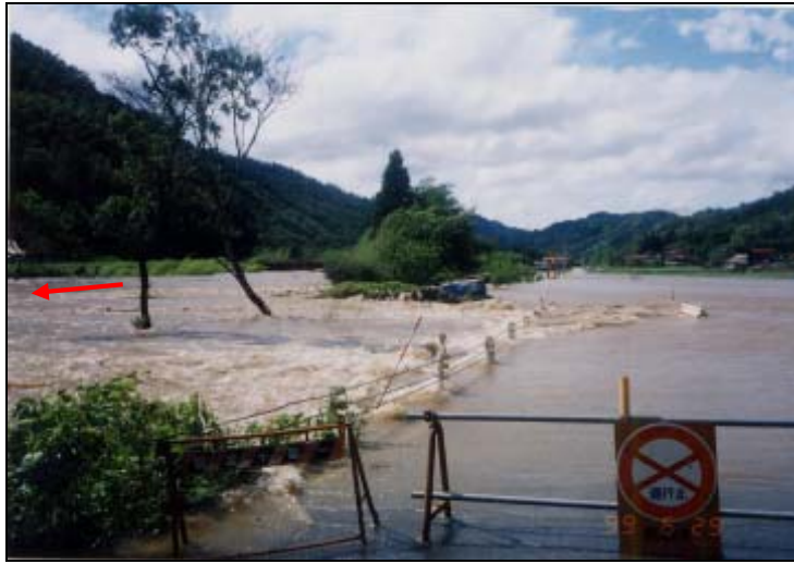
写真-3.1.1 津和野川：津和野町田二穂（平成 11 年 6 月）
