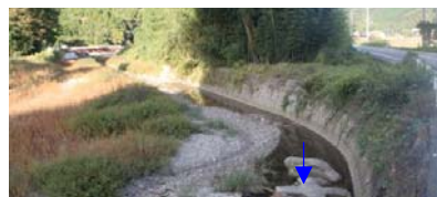
⑧陣賀堰上流湾曲部
