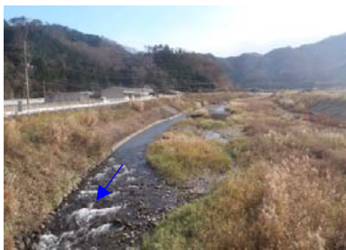
④河口橋付近上流
