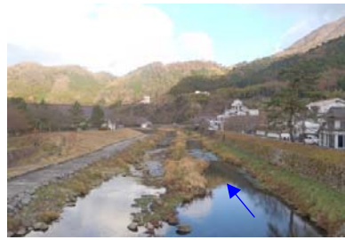
⑮津和野大橋下流
