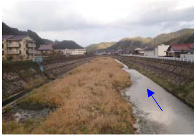
⑯常盤橋下流
