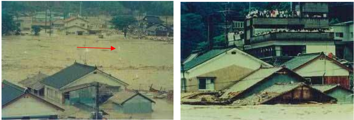
写真-1 昭和58年7月豪雨時の被災状況
