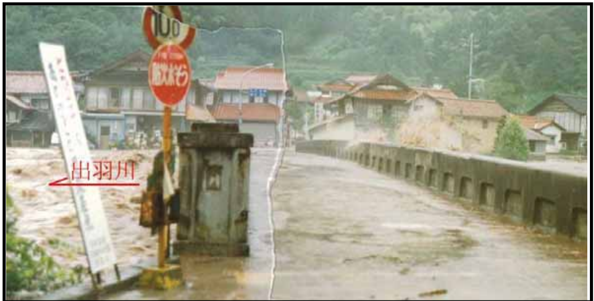
写真3.2 出羽川：琵琶甲橋（昭和58年7月洪水）
