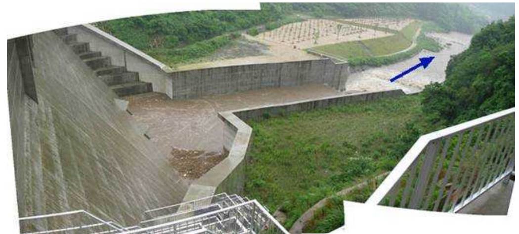
【ダム下流側 減勢工】
