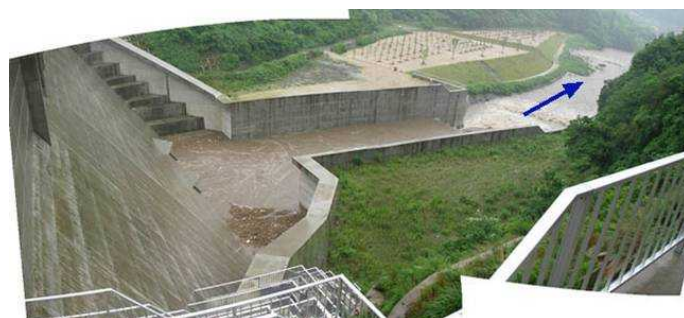
【ダム下流側 減勢工】
