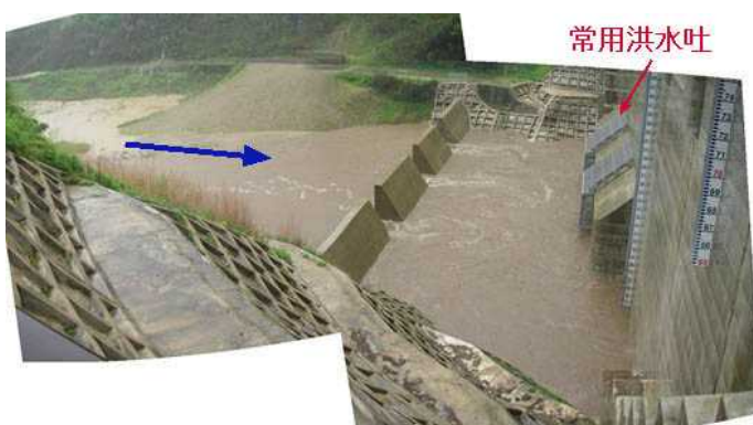
【ダム上流側 常用洪水吐】
