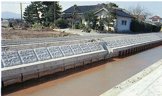
三分市地区農業排水路（宍道町） 排水路護岸に化粧型枠を使用
