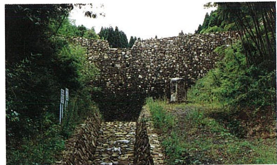
永泉寺谷川（大田市） 周辺の自然に溶け込んでいる石張り工法
