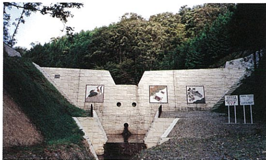
大杉谷川（三隅町） 擬石型枠・アートパネルを使用している
