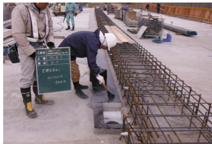
防水工 施工状況(塗布)
