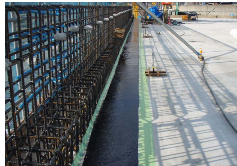
鋼製排水溝下面への防水工 完了状況
