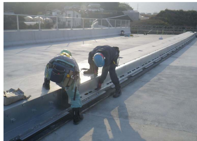
鋼製排水溝 取付け完了状況
