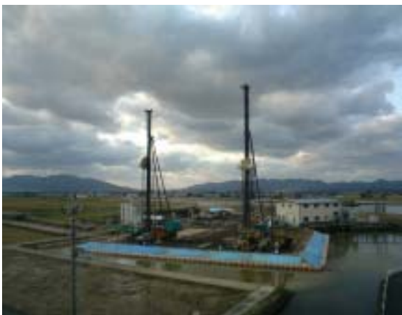
深層混合処理工機2台による地盤改良状況
