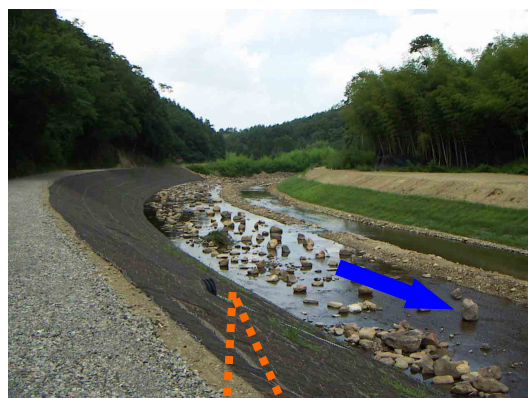
実施状況写真
