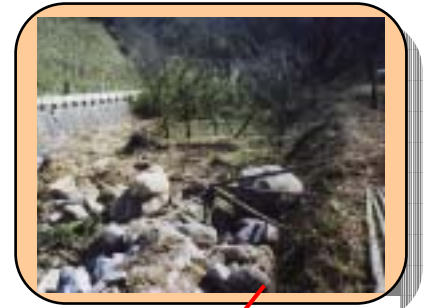
改修前河川状況写真
