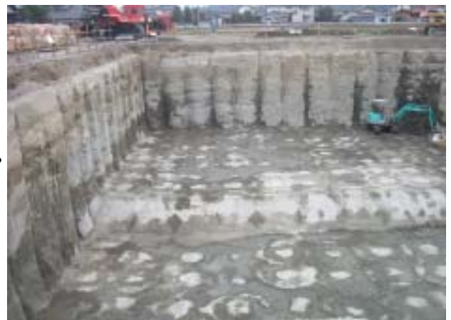
地盤改良完了後、吸水槽構築部を掘削した状況
