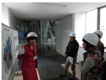
(火力発電タービン室)
