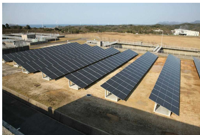
江津浄水場太陽光発電所
