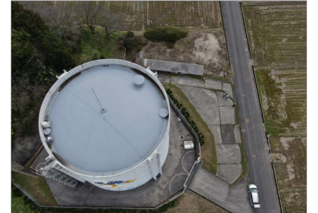
(4) ドローンによる飯島配水池点検訓練(飯梨川工水)
