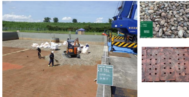
(1)今津浄水場 6号ろ過池更生工事
