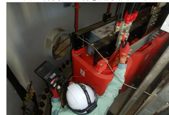
(4) 江津高野山風力発電所点検作業(風車内)
