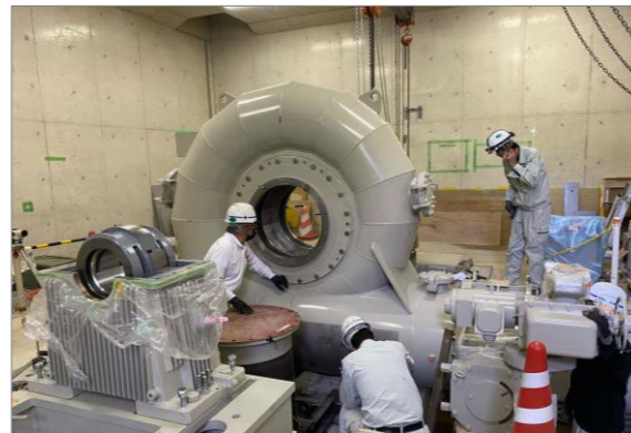
(2) 勝地発電所リニューアル工事(水車設置状況)
