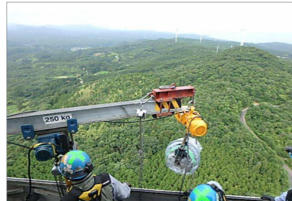
(3) 江津高野山風力発電所 増速機軸受搬入(8号機)
