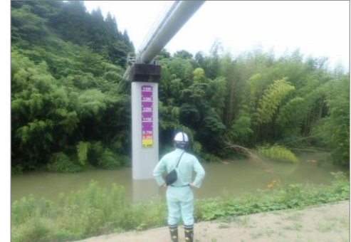
(4)特別巡視状況(西部事務所:都治川水管橋)
