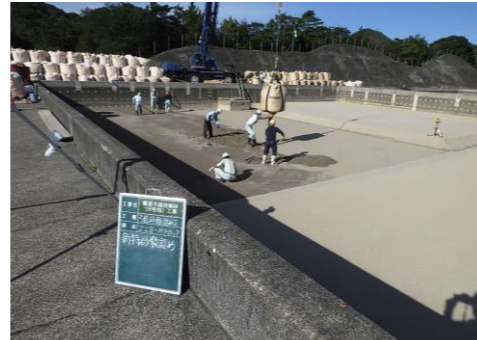
(2)江津浄水場 6号ろ過池補砂工事
