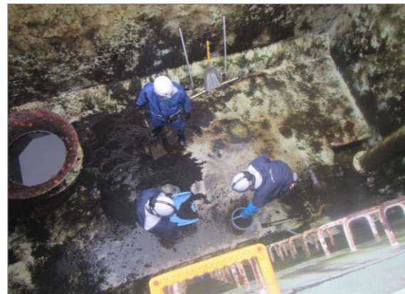
(2) 着水井清掃(今津浄水場)
