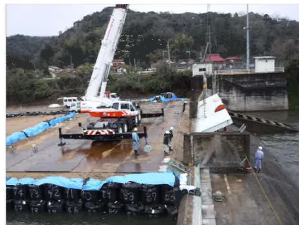
(1)逆調整池転倒ゲート更新工事(東部事務所)
