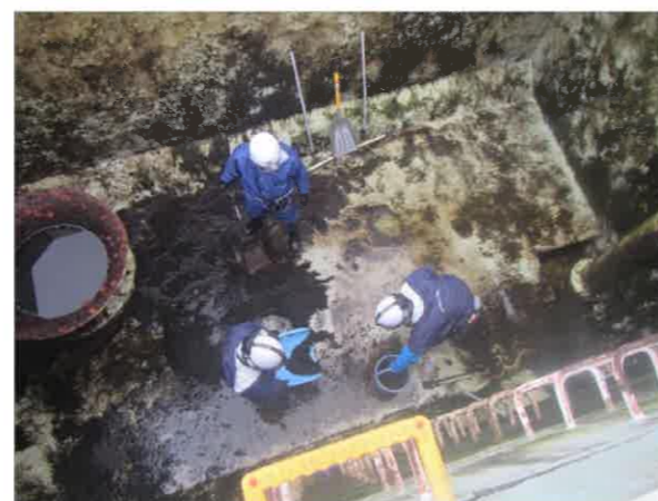
(2)着水井清掃(今津浄水場)
