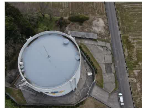
(3)ドローン空撮訓練(飯島配水池)
