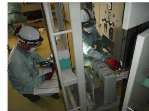
(4) 全停電作業(今津浄水場)
