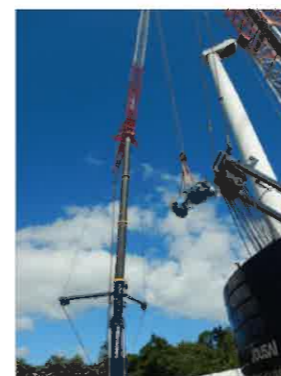
(3) 主軸受取替工事(高野山風力発電所7号機)
