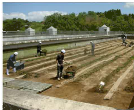
(2) ろ過池砂削り工事(三代浄水場)
