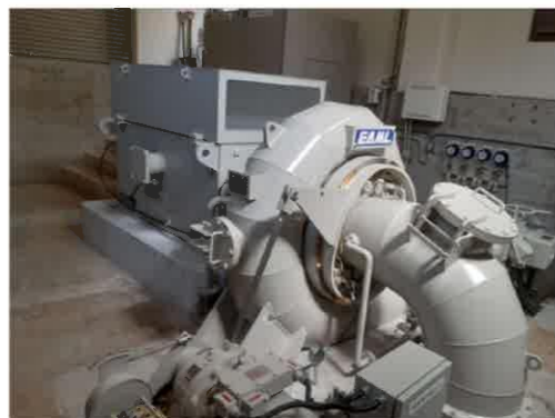
(1) FIT運転開始(飯梨川第三発電所)
