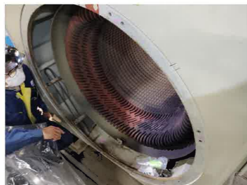
(2) 発電機修理中(八戸川第一発電所2号機)
