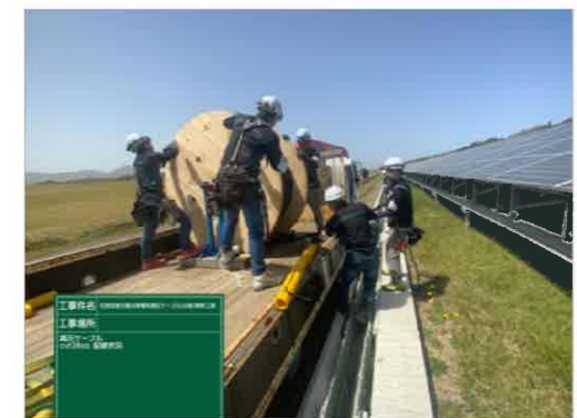
(4) 電力ケーブル交換(石見空港太陽光発電所)
