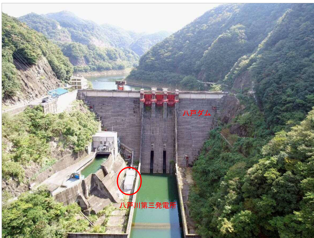
(6)八戸川第三発電所（現地着工前:令和6年3月運転再開予定）
