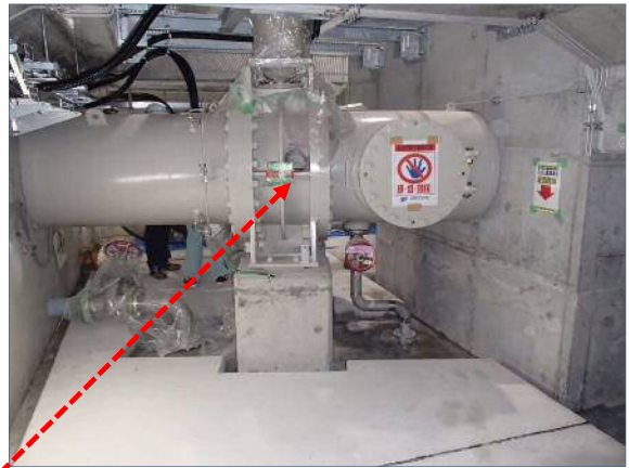
水圧鉄管・水車外部・入口弁 (地下3F)
