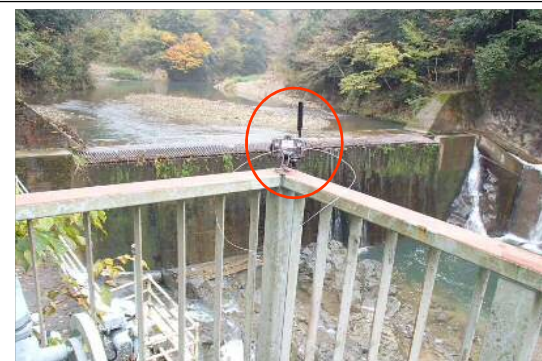
③勝地発電所取水口監視カメラ
