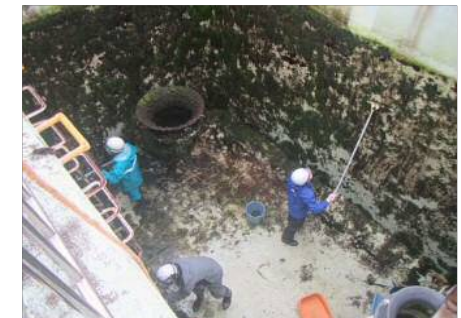
④着水井清掃(今津浄水場)
