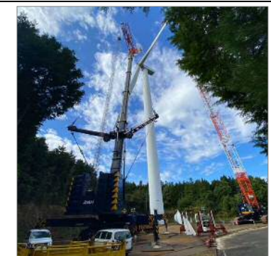
④1号主軸取替(高野山風力発電所)
