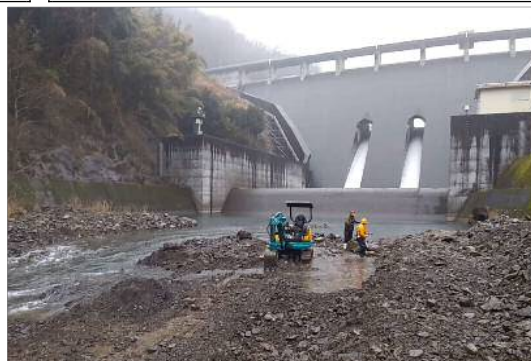
②御部発電所放水口堆積土砂除去
