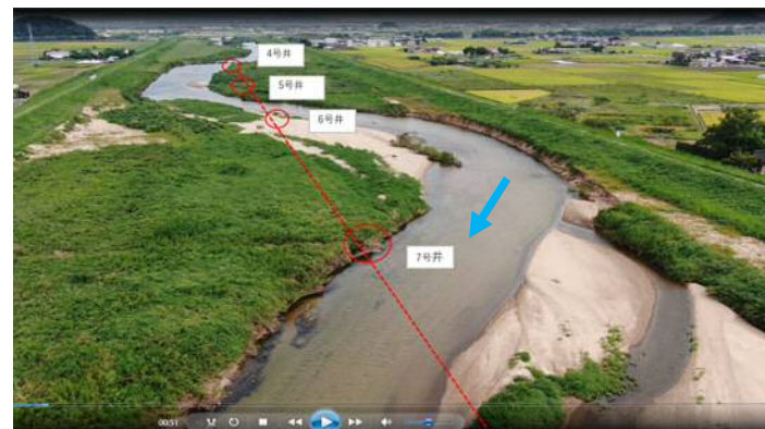
②ドローンによる集水埋渠点検(今津浄水場)
