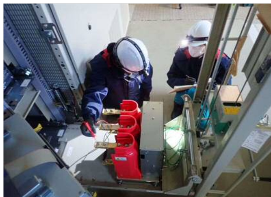
①取水設備定期点検(江の川工水)
