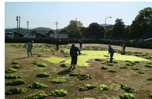
③ろ過池砂削り取り作業(江津浄水場)
