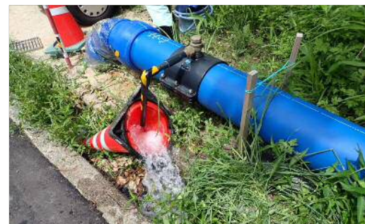
①仮設管に送水切替(斐伊川水道)
