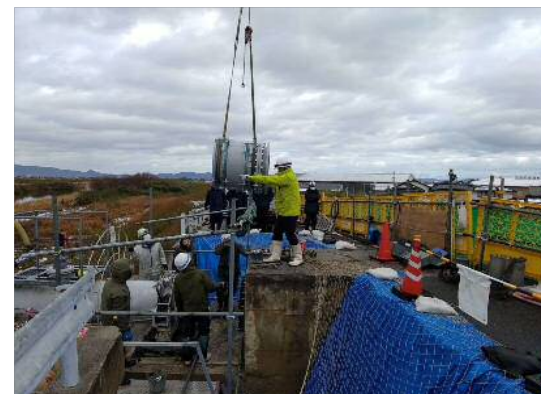
③飯梨川水管橋伸縮継手取替工事(飯梨川工水)
