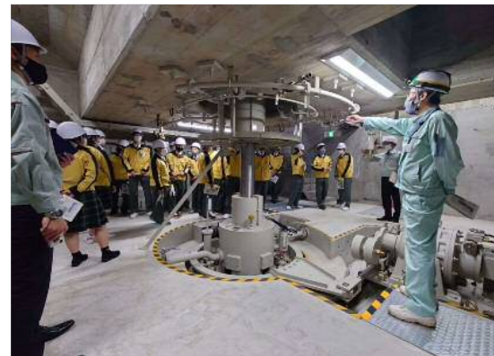
①飯梨川第一発電所見学(松江工業高校)
