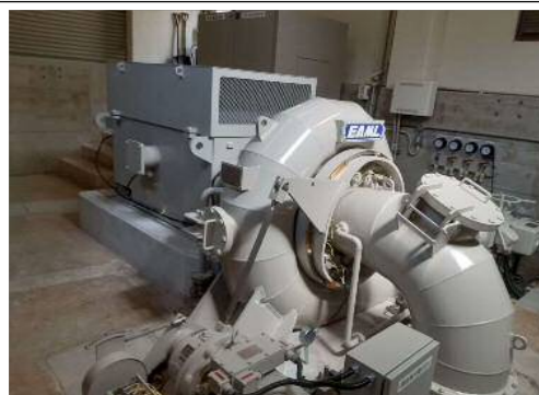
①リニューアル完了(飯梨川第三発電所)
