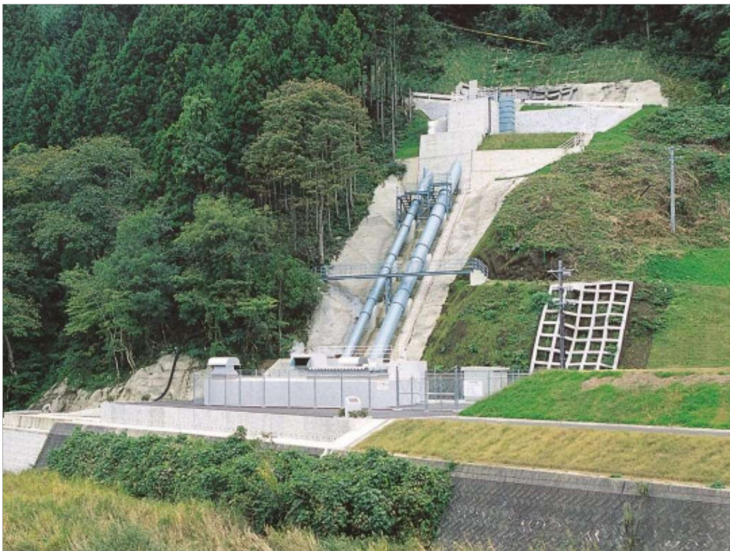
(5)勝地発電所（現地着工前:令和5年12月運転再開予定）
