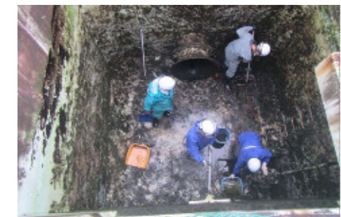
④着水井清掃(今津浄水場)
