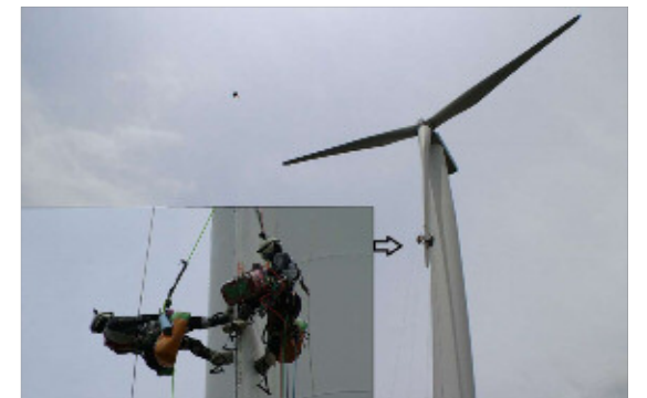
④ブレード点検(高野山風力発電所)
