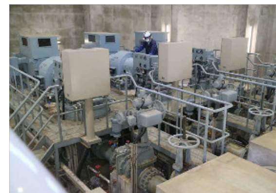
③取水ポンプ設備点検(江の川取水場)
