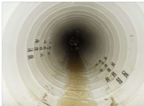
②導水路変状補修完了(飯梨川第一発電所)
