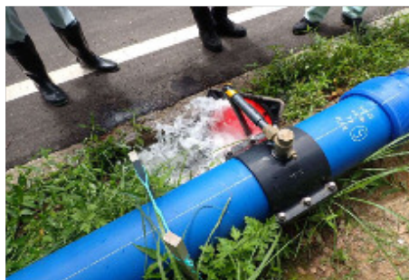
①仮設管に送水切替(斐伊川水道)
