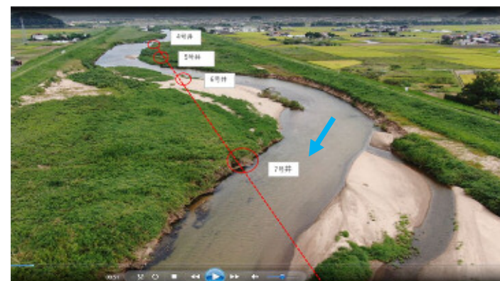
②ドローンによる集水埋渠点検(今津浄水場)
