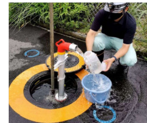
④送水管路での水質検査(飯梨川工水)
