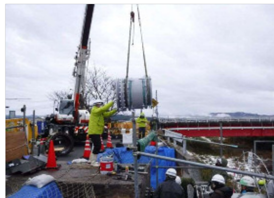
①飯梨川水管橋伸縮継手取替工事(飯梨川工水)
