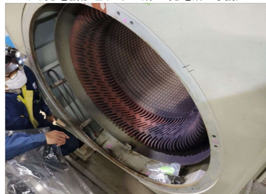
(2) 発電機修理(八戸川第一発電所2号機)
