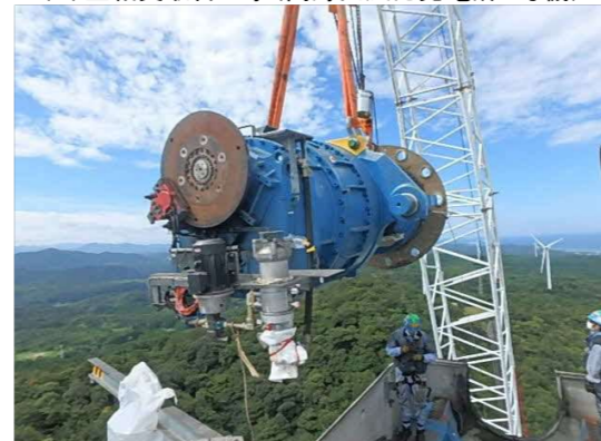
(3) 主軸受取替工事(高野山風力発電所7号機)
