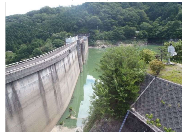
(3) 濁水時の布部ダム
