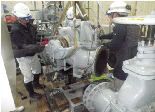
(1) 送水ポンプ オーバーホール工事(江津浄水場)
