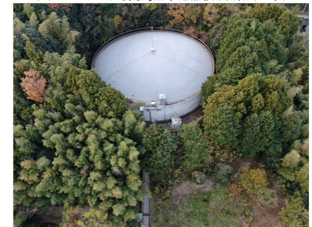
(4) ドローンによる荒島配水池点検(飯梨川工水)
