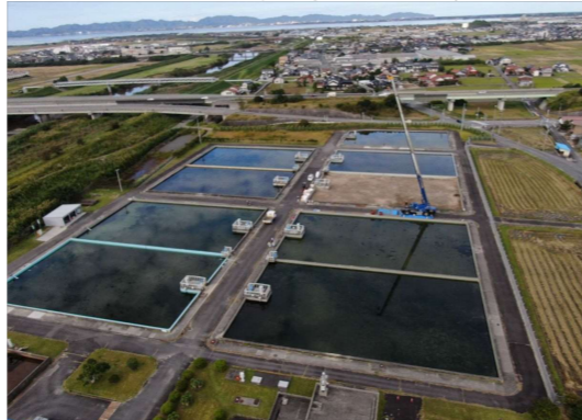
(2) ろ過池補砂工事(今津浄水場)
