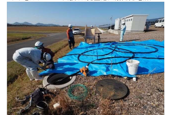
(4) 電力ケーブル交換(石見空港太陽光発電所)
