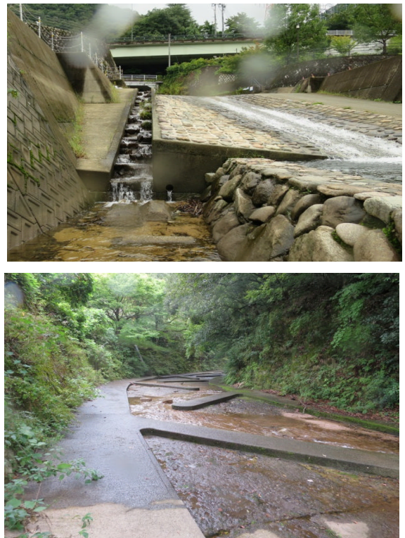
図5. 熊見川合流点の魚道（上）と魚道の上流側のコンクリート河道（下）
