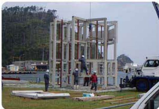
ぎょじょう くみたて 魚礁の組立
