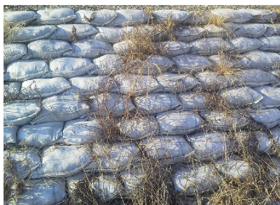
土のうによる漏水防止対策
