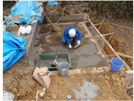
底版コンクリート欠損部分のモルタル充填状況
