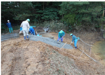
張コンクリート敷均し状況
