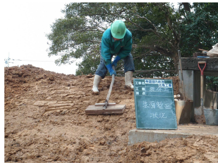
盛土法面仕上げ状況
