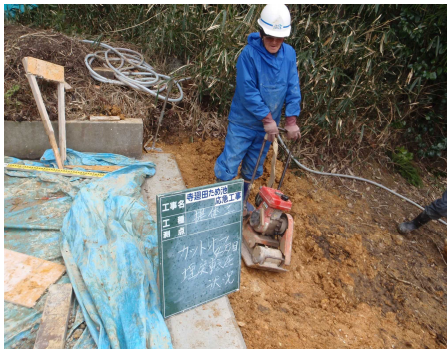
埋戻締固め状況
