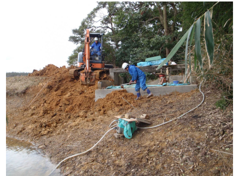
カットオフ埋戻 バックホウ投入・人力まき 出し状況
