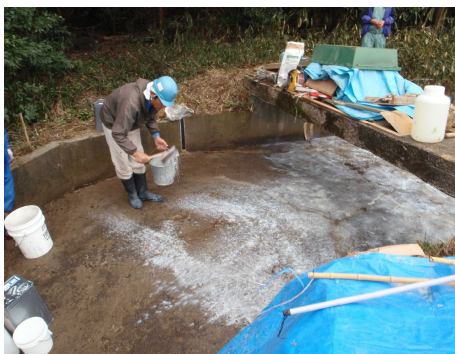
下地プライマー塗布状況
