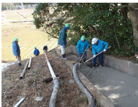
コンクリート打設状況
