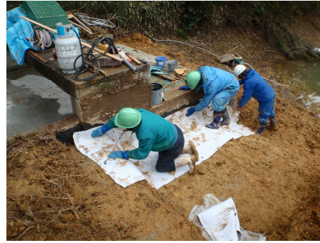
ベントナイトシート敷設状況
