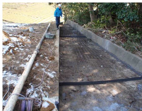
目地板及び鉄筋金網(D6)設置状況
