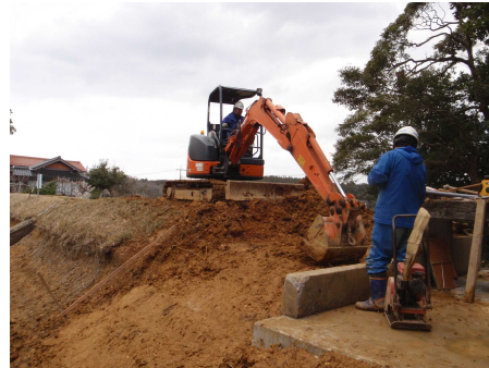
盛土敷均状況
