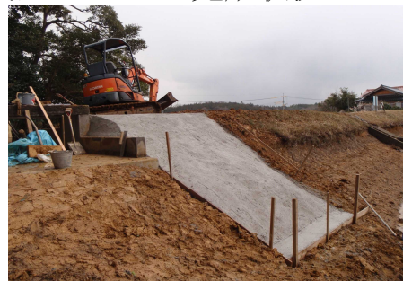
張コンクリート完成状況
