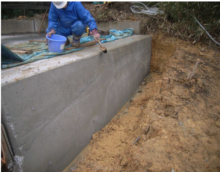
カットオフ躯体完成状況
