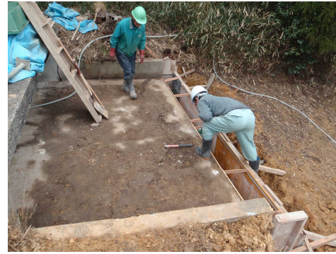
型枠施工状況
