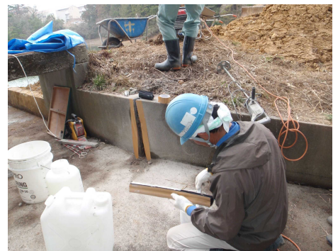
接着用エポキシ樹脂塗布
