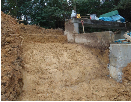
堤体掘削・段切り状況
