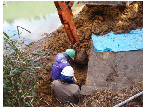
人力による床堀状況
