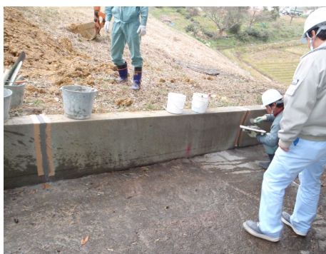
耐摩耗性ポリマーセメントモルタル塗布状況
