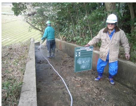
底版コンクリート面の洗浄状況
