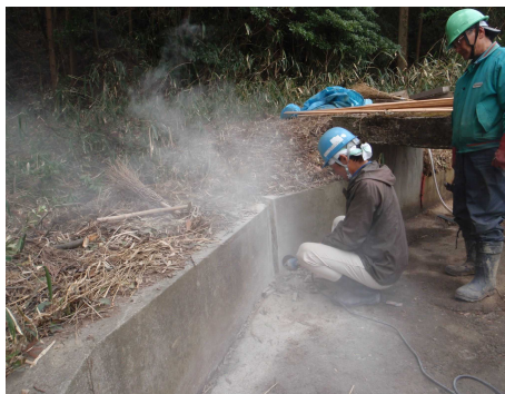
カッター切断状況
