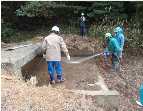
底版コンクリート面の洗浄状況
