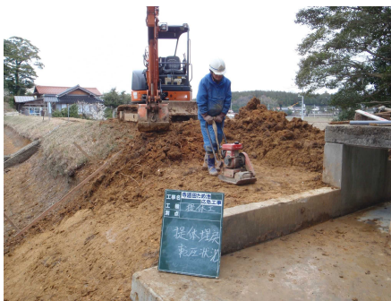
盛土転圧状況
