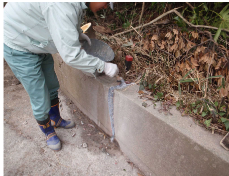
アクリル系プライマー塗布状況
