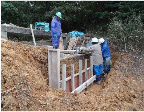
型枠施工状況
