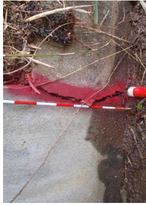
余水吐側壁の老朽化状況
