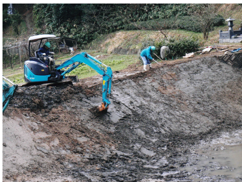
盛土法面仕上状況
