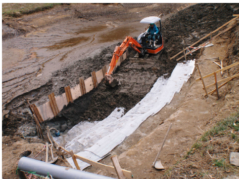
まき出し・敷均し状況
