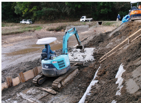
セメント安定処理(バックホウによる散布・混合)状況
