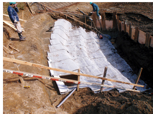
シート敷設状況
