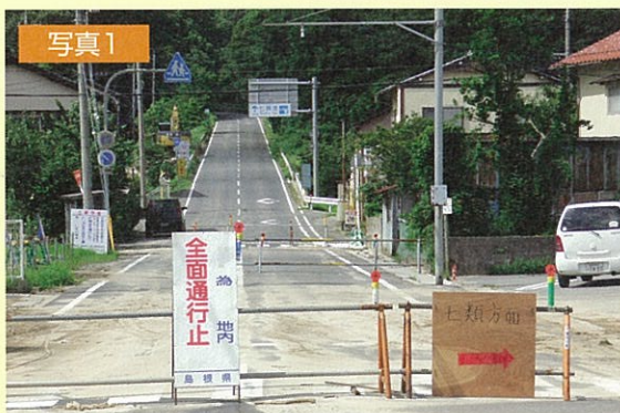
▲国道485号線→市道への迂回路表示
