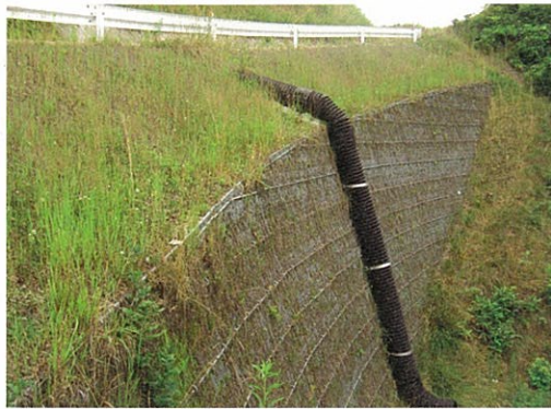
補強土壁工の採用
