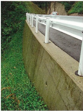
コンクリート擁壁
