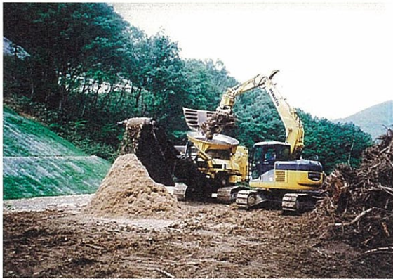
伐根等をチップ化し法面緑化の基盤材として利用
