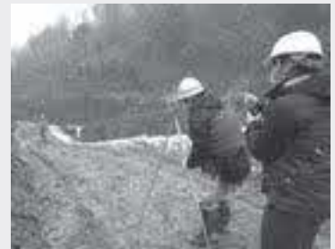
森林作業道の検査
