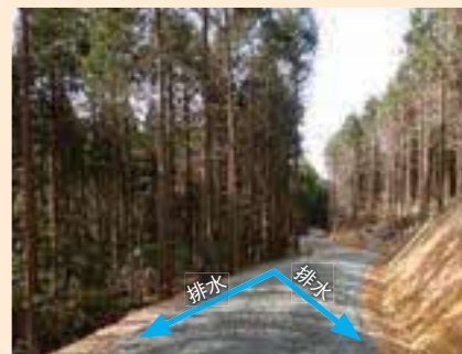
路面排水を考慮した屋根形作業道
