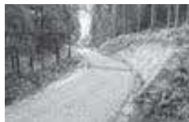
林業専用道整備
