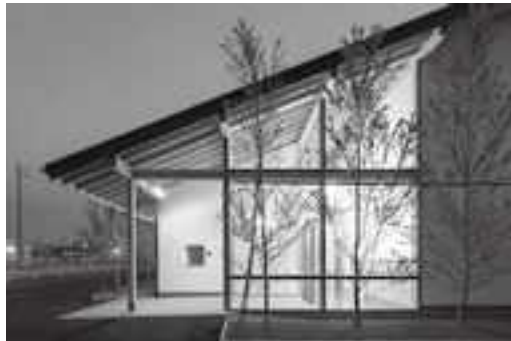
写真2 天井の木材が直接見える入り口付近
