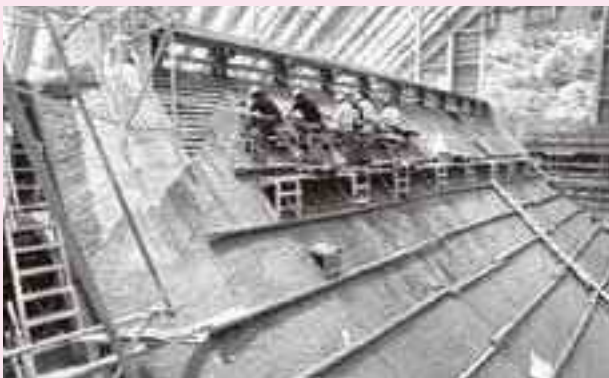
出雲大社本殿檜皮葺替え作業
