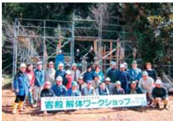
移築に向けて解体する様子
