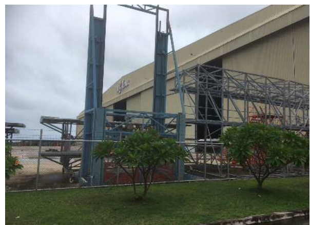
タイ航空航空機整備場
