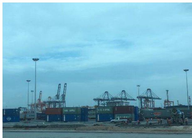
コンテナターミナルのガントリークレーン
