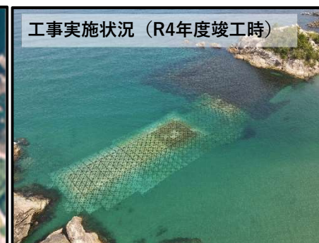
工事実施状況 (R4年度竣工時)
