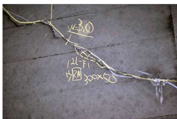
覆工アーチ部のひび割れ
