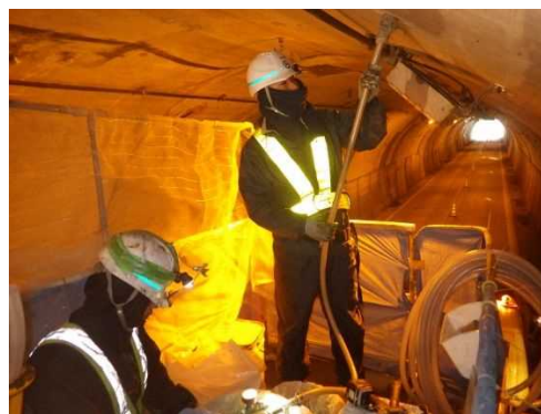
裏込注入状況
