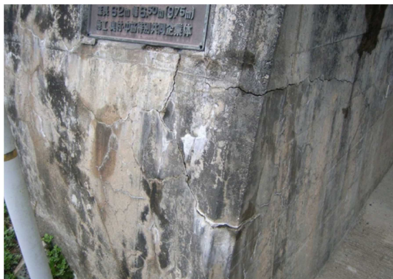
抗門面壁のひび割れ
