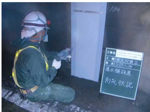
写真 3-2 線導水工
