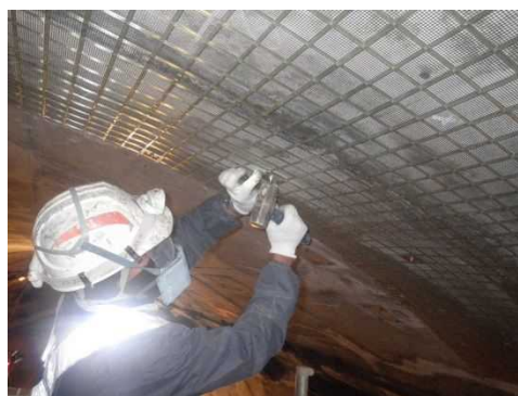
写真 3-1 FRP ネット設置状況
