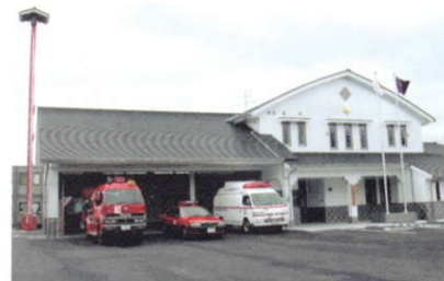
新たに分署を設置した例
