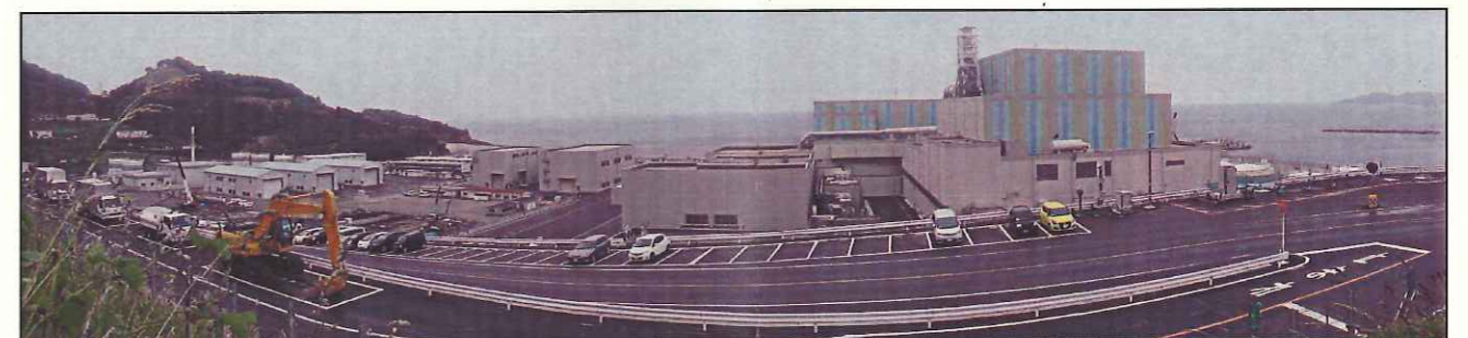
敷地南側からの全景
