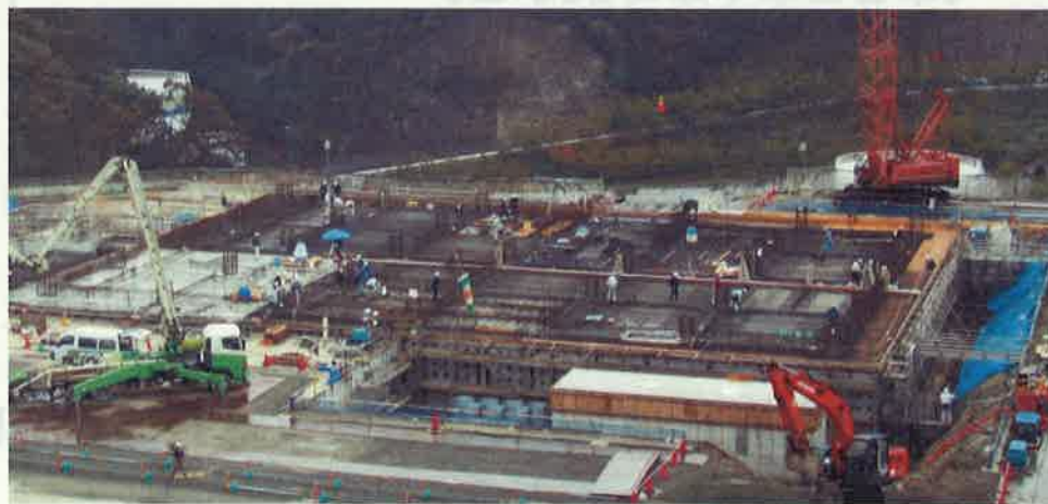
▲基礎工事の様子（平成25年10月現在）
