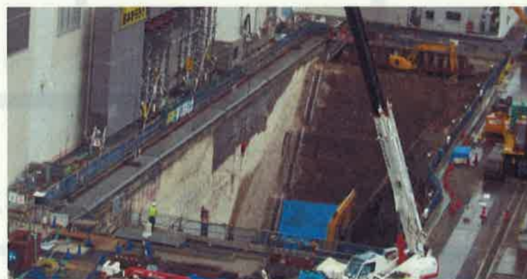
▲2号機フィルタ付ベント設備工事状況
