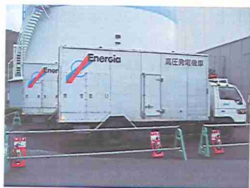
高圧発電機車(500kVA)
