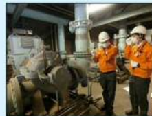
火力発電所での現地研修
