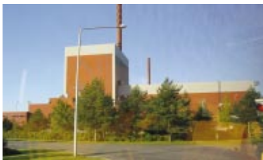
オルキルオト原子力発電所
