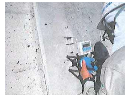
図6 付着強度試験実施状況
