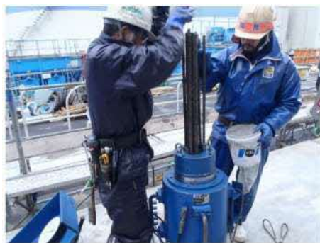
図2 グラウンドアンカ施工状況
