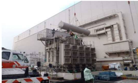
撤去作業の状況
