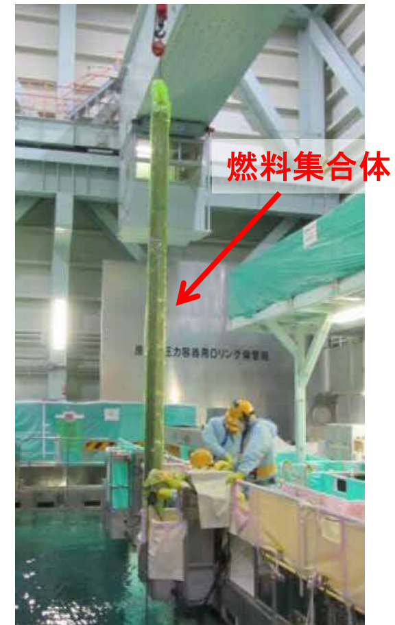
新燃料の引き上げ状況
