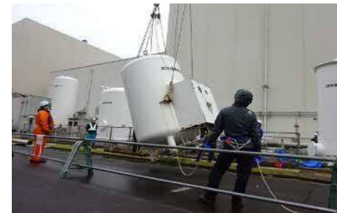
撤去作業の状況
