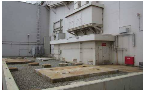
撤去作業後の状況
