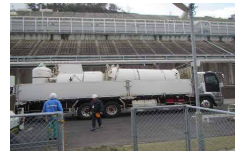
解体物の移送
