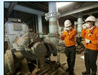
火力発電所での現地研修
